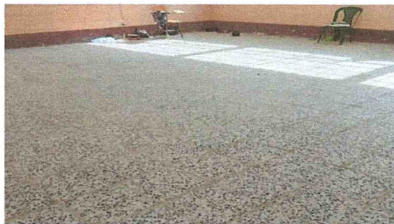
Foto 1: Sustitución de piso de concreto a piso de granito en un aula segundo nivel
