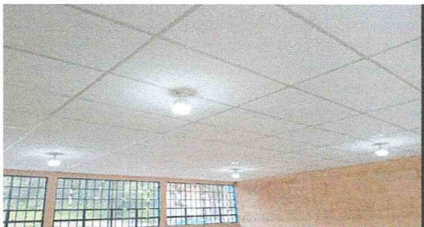
Foto7: Sustitución de focos a bombillas led en dos aulas
