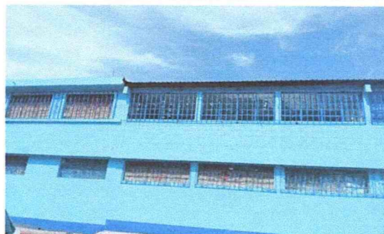
Foto 4: Mantenimiento de balcones fachada de escuela
