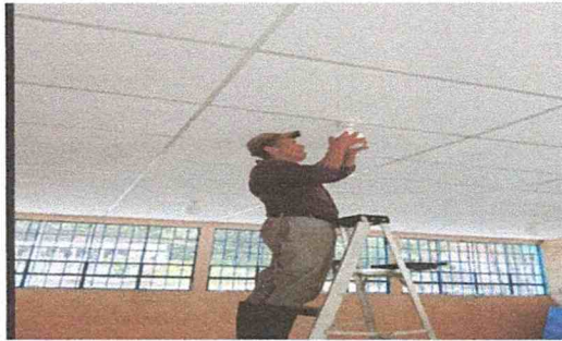
Foto 7: Sustitución de focos por bombillas led en dos aula segundo nivel
