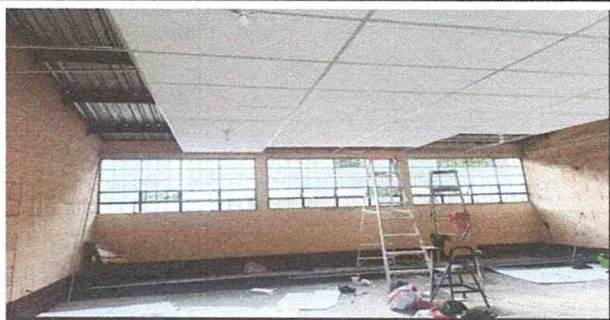
Foto 5: Instalando cielo falso en aula segundo nivel
