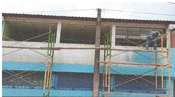
Foto 3: Desmontando estructura de metal de ventanas y vidrios
