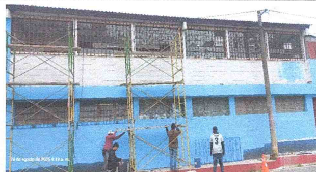
Foto 4: Mantenimiento de balcones fachada escuela
