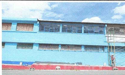
Foto 6: Aplicando pintura en paredes exteriores
