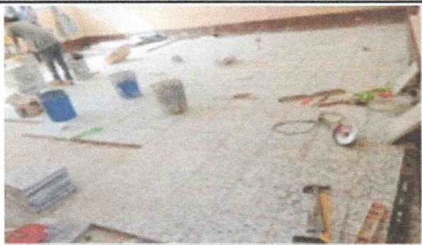
Foto 1: Colocando piso de granito en aula segundo nivel
