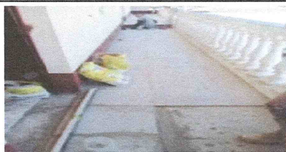
Foto 2: Colocando piso cerámico en pasillo
