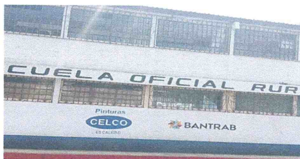
Foto 4: Mantenimiento de balcones fachada de escuela
