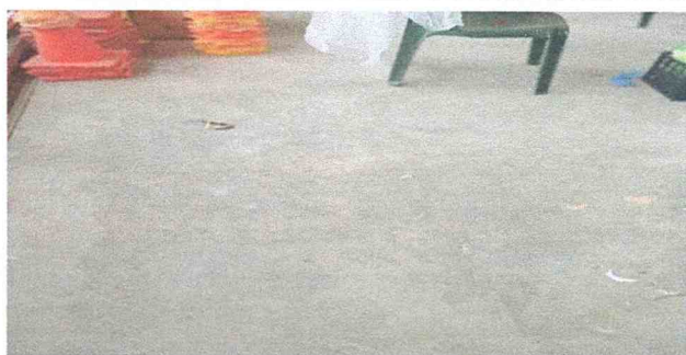
Foto 1: Mantenimiento sustitución de piso de concreto a piso de granito en un aula segundo nivel
