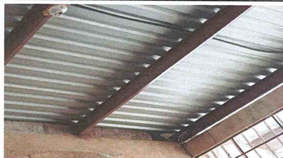
Foto 5: Instalación de cielo falso en dos aulas segundo nivel
