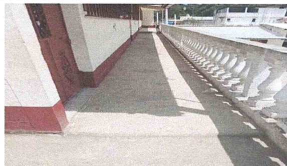
Foto 2: Mantenimiento sustitución de piso de concreto a piso cerámico en pasillo
