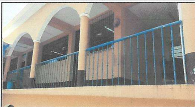
Anclaje de baranda a columna circular
