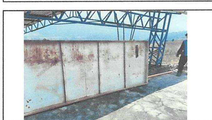
Baranda con marco y tablero metalico de 1M con 4 capas de pintura anticorrosiva
