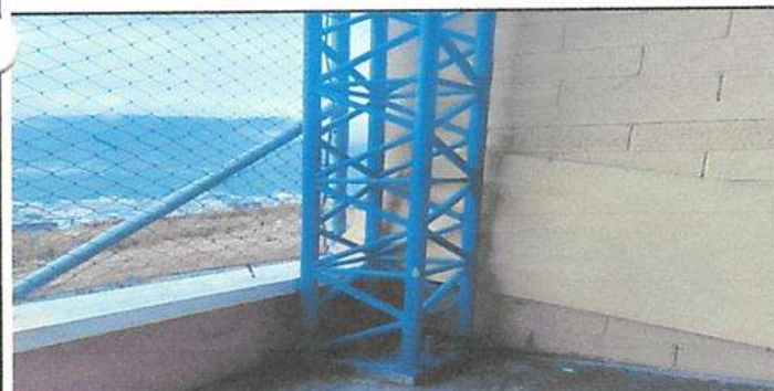
Forro de 2 columnas en escenario con lamina negra 3/16 y pintura anticorrosiva
