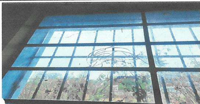
Suministro e Instalacion de 14 vidrios de 5mm incluye desmontaje de vidrio existente
