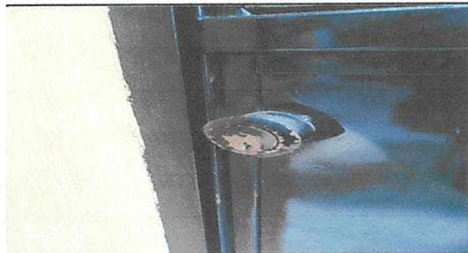
Sustitucion de chapa
