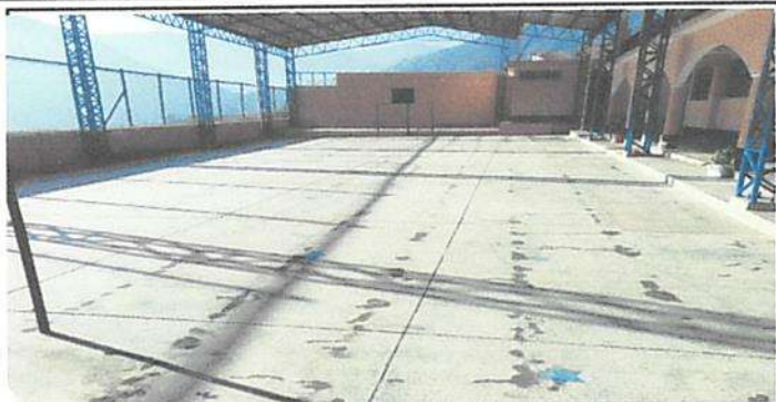
Suministro y aplicación de pintura para marcaje de cancha polideportiva con fondo completo, con pintura especial para cancha ( 10.5 x 20 Metro)
