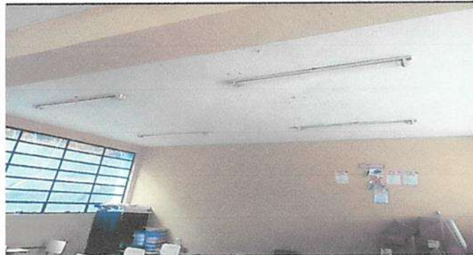
Sustitucion de lamparas de tubos fluorescente por 118 tubos Led de 1x4 18w-120v.
