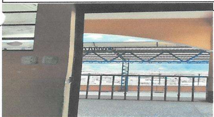
Mantenimiento de marco de puerta
