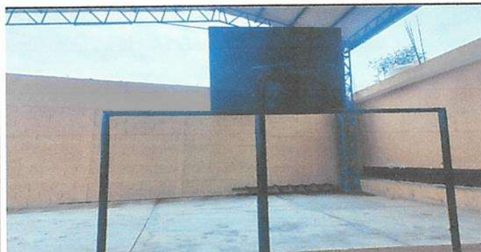
Sustitución de 2 Marcos y 2 Tableros de basquetbol
