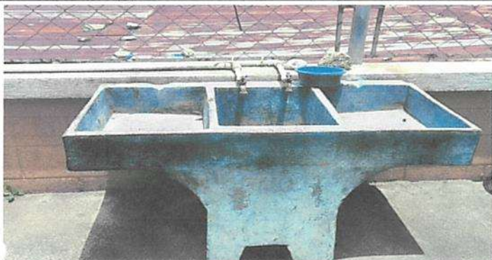
Sustitución de 2 pilas de concreto y mantenimiento de drenaje y agua potable
