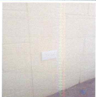
13 unidades de Sustitución de tomacorriente de doble toma
