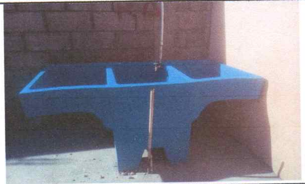
1 unidad de Sustitución de pila prefabricada de concreto
