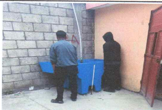
1 unidad de Sustitución de pila prefabricada de concreto
