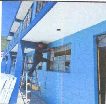
16 unidades de Sustitución de ventana con marco de aluminio blanco
