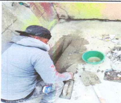
1 unidad de Mantenimiento preventivo de cajuela de pila con fundición de concreto
