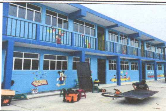
6 unidades de Mantenimiento correctivo de puerta de metal con pintura anticorrosiva + sustitución de chapa
