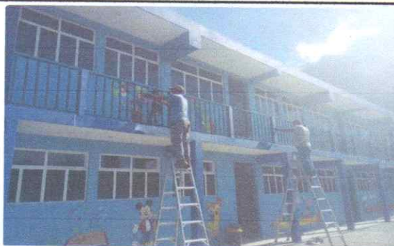
35 metros cuadrados de Mantenimiento preventivo de barandas de metal (limpieza + aplicación de pintura anticorrosiva)
