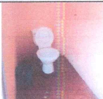
Sustitución de sanitarios institucionales + accesorios
