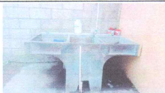
Sustitución de pila prefabricada de concreto
