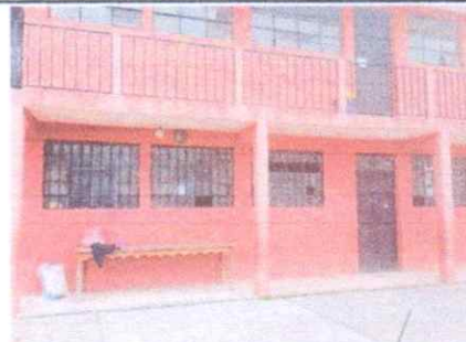
Mantenimiento preventivo de barandas de metal (limpieza + aplicación de pintura anticorrosiva)
