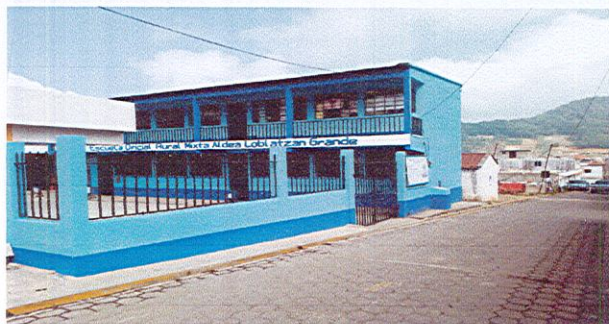
Suministro de pintura interior y exterior
