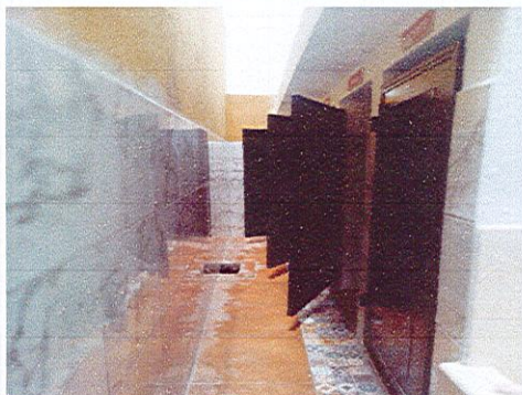
Reparación de puertade metal de baños
