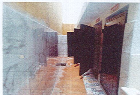
Mantenimiento de servicios sanitarios con ceramicas
