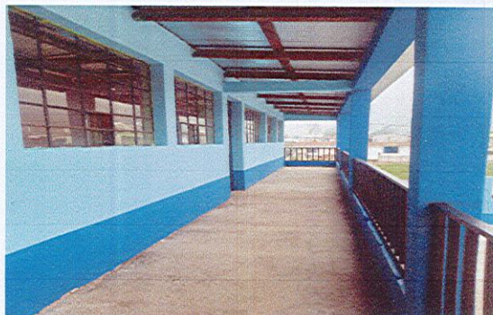
Suministro de pintura interior y exterior, mantenimiento de balcones de metal con pintura
