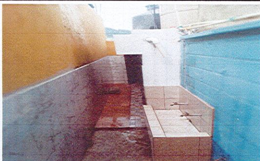
Sustitución de aparatos sanitarios y sus accesorios.
