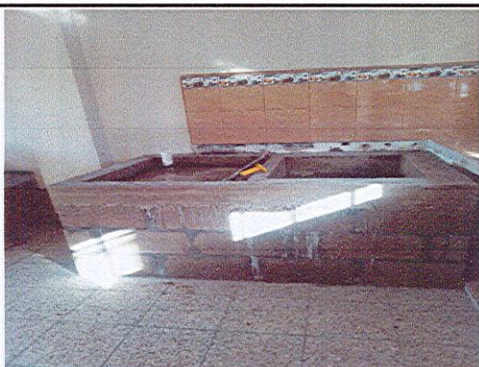
Sustitución de pregadero de concreto con deposito de agua.
