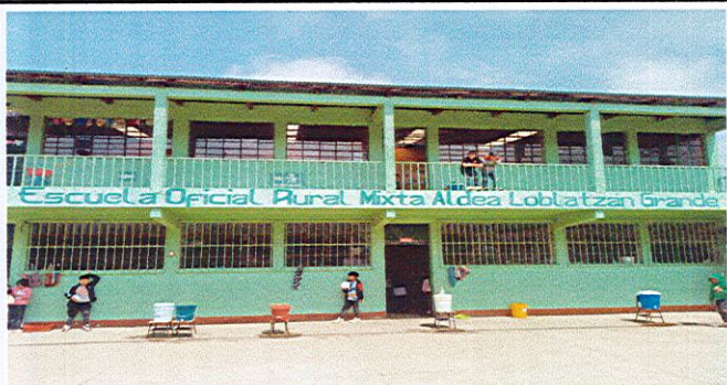
Suministro de pintura interior y exterior, mantenimiento de balcones de metal con pintura
