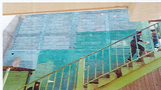
Suministro de pintura interior y exterior, mantenimiento de balcones de metal con pintura
