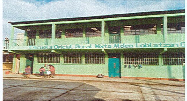
Matenimiento de balcones de metal con pintura
