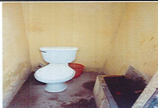
Sustitución de mingitorio seco y sus accesorios
