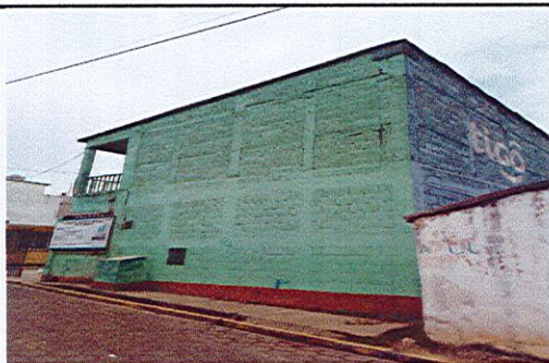
Suministro de pintura interior y exterior
