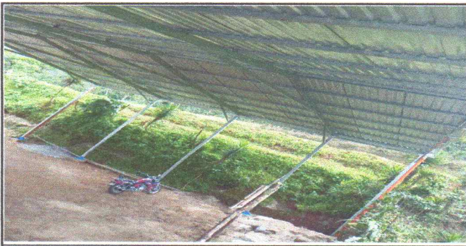
No.1 Sustitución de parales de madera por cubierta de estructura metálica.
