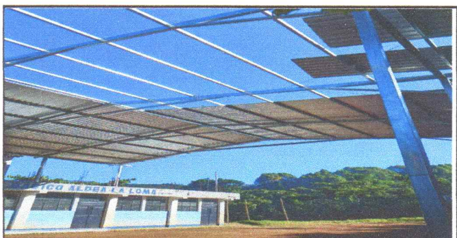
No. 2 Sustitución de cubierta de lámina consistente en techo de lámina troquelada calibre 26 de Aluzinc en área recreativa.
