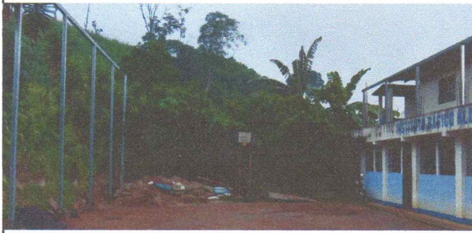
No.1 Sustitución de parales de madera por cubierta de estructura metálica.
