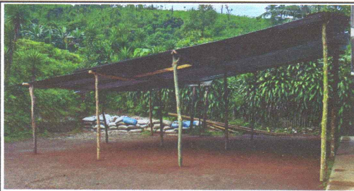
No.1 Sustitución de parales de madera por cubierta de estructura metálica, consistente en estructura de tubo galvanizado de 6", 5" y o 4" chapa 14, costanera de 4" por 2" de 1.5 de espesor, en área recreativa.
