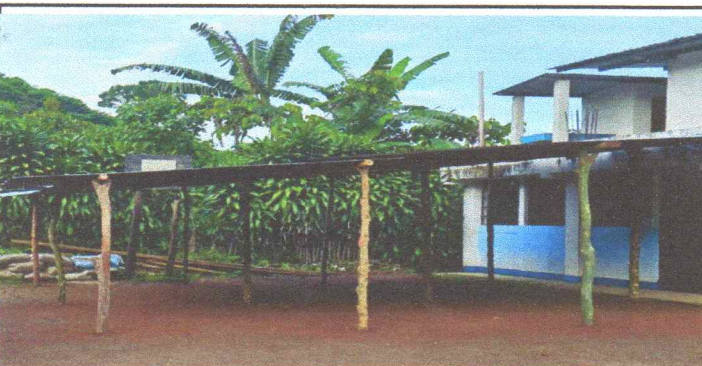
No.1 Sustitución de parales de madera por cubierta de estructura metálica, consistente en estructura de tubo galvanizado de 6", 5" y o 4" chapa 14, costanera de 4" por 2" de 1.5 de espesor, en área recreativa.
