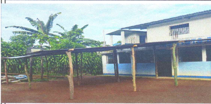
No.1 Sustitución de parales de madera por cubierta de estructura metálica, consistente en estructura de tubo galvanizado de 6", 5" y o 4" chapa 14, costanera de 4" por 2" de 1.5 de espesor, en área recreativa.
