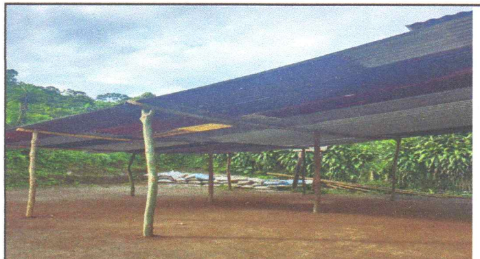
No. 2 Sustitución de cubierta de lámina consistente en techo de lámina troquelada calibre 26 de Aluzinc en área recreativa.
