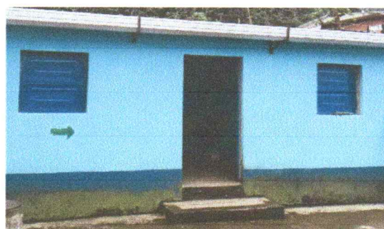
Sustitución de ventanas metálicas en cocina.
