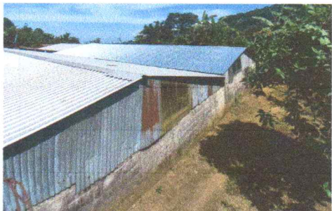
Sustitución de lamina troquelada cal.26 en cubierta de salón.
