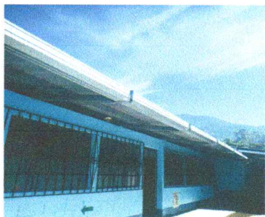
Sustitución de canales para aguas pluviales de cubierta.
