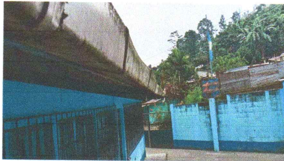
Sustitución de canales para aguas pluviales de cubierta.
