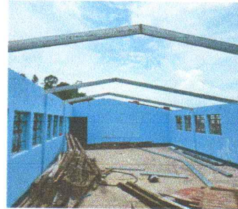
Sustitución de estructura metálica en cubierta de salón.
