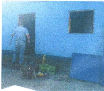
Sustitución de puerta metálica en cocina.
