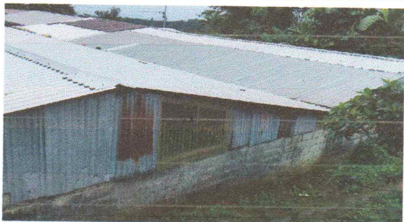
Sustitución de lamina troquelada cal.26 en cubierta de salón.
