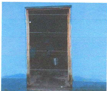
Sustitución de puerta metálica en cocina.
