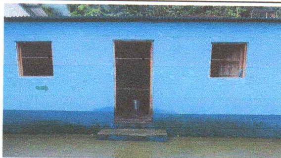
Sustitución de ventanas metálicas en cocina.
