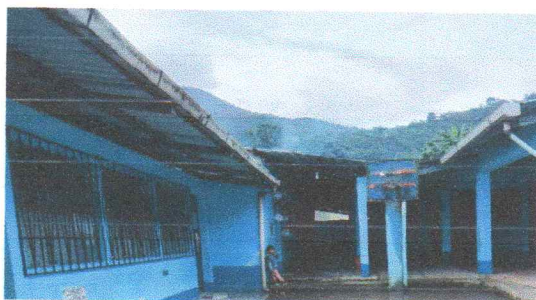
Sustitución de canales para aguas pluviales de cubierta.
