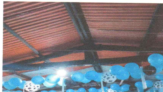
Sustitución de estructura metálica en cubierta de salón.
