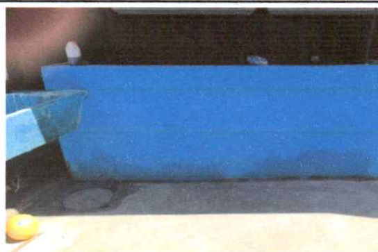
Reparación de lavamanos en la parte inferior 6 mt2
