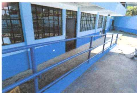
Reparación baranda y arreglos 1 unidad
