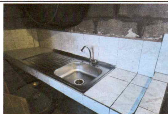
Sustitución de lavatrastos + grifo en cocina 1 unidad
