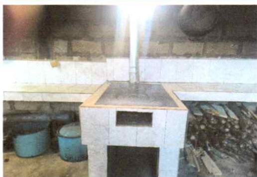
Sustitución de estufas móviles por estufas de concreto en cocina 2 unidades
