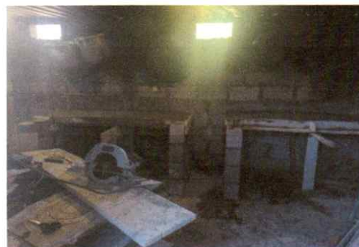
Sustitución de mesa de trabajo de madera por mesa de concreto en cocina 1 unidad
