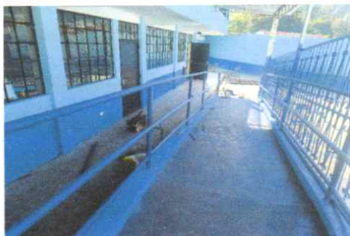
Reparación baranda y arreglos 1 unidad
