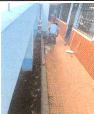
Sustitución y mantenimiento piso de concreto paso tubería de drenaje 22 mt2
