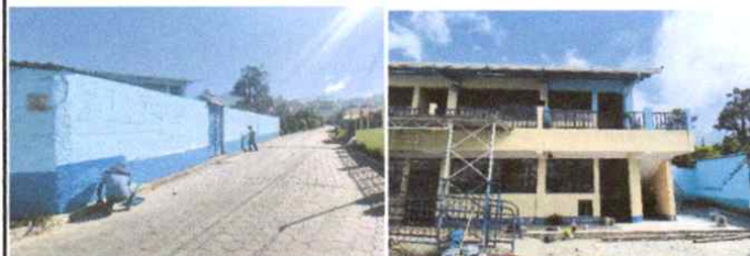
Mantenimiento preventivo de pintura en muros de edificio escolar 511.25 mt2
