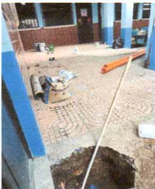
Sustitución de tubería pvc 4" de drenaje 12 mts lineales
