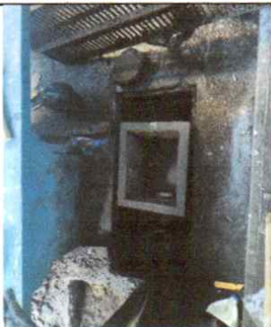
Sustitución y mejoramiento de dos cajas trampa 2 unidades
