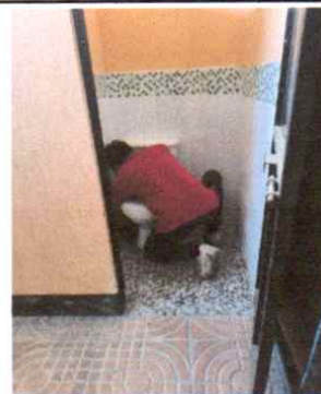
Sustitución de tubería pvc de 3" en red de drenaje de sanitarios 10 mts lineales
