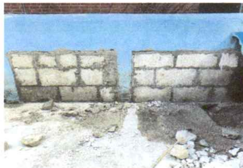
Reparación de lavamanos en la parte inferior 6 mt2
