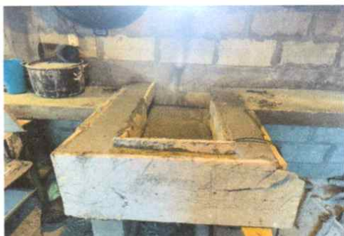
Sustitución de estufas móviles por estufas de concreto en cocina 2 unidades
