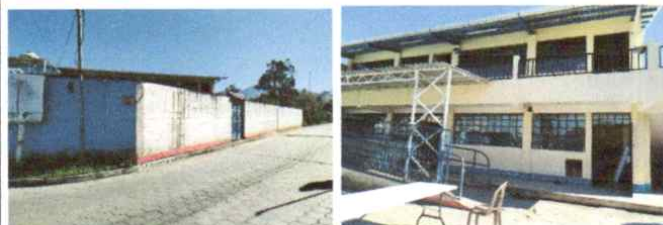
Mantenimiento preventivo de pintura en muros de edificio escolar
