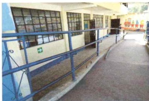
Reparación baranda y arreglos
