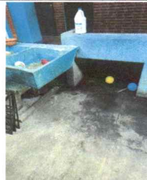
Reparación de lavamanos en la parte inferior
