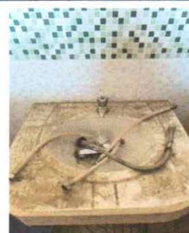
Sustitución de tubería pvc de 1/2" en red hidráulica de sanitarios
