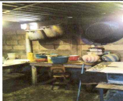
Sustitución de mesa de trabajo de madera por mesa de concreto en cocina
