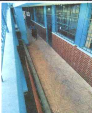
Sustitución y mantenimiento piso de concreto paso tubería de drenaje
