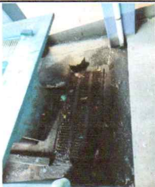
Sustitución y mejoramiento de dos cajas trampa
