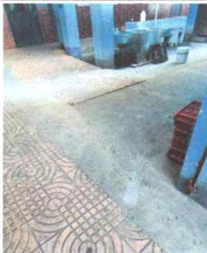
Sustitución de tubería pvc 4" de drenaje
