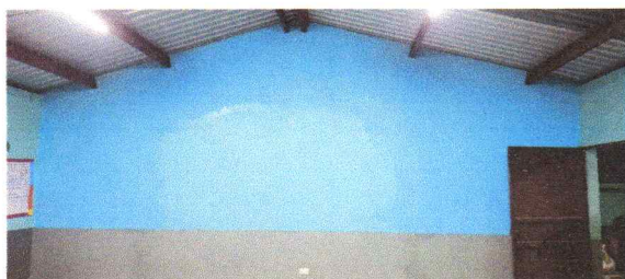
Foto 11: Sustitución de repello en pared
