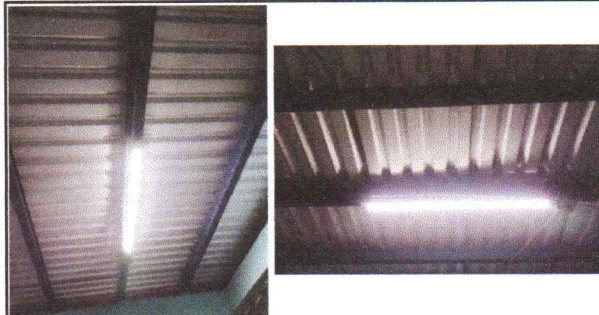
Foto 2: Sustitución de luminarias
