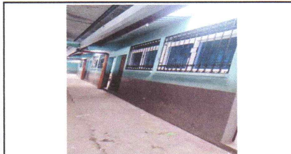
Foto 5: Sustitución de ventanas en pvc
