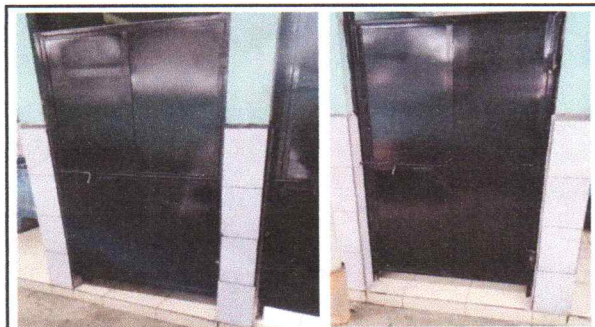
Foto 3: Sustitución de puertas metálicas en baños
