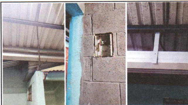
Foto 8: Sustitución de cableado eléctrico
