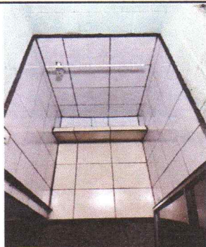
Foto 9: Sustitución de mingitorio de concreto con revestimiento de Azulelos
