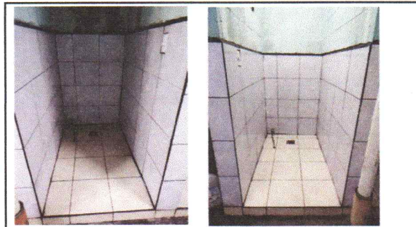
Foto 4: Colocación de Azulejos en baños
