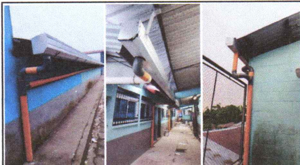
Foto 1: Sustitución de canal de metal en cubierta
