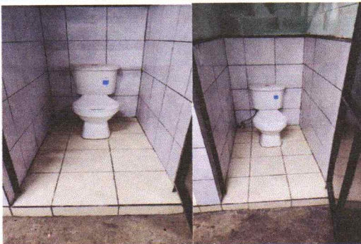
Foto7: Sustitución de inodoros sanitarios
