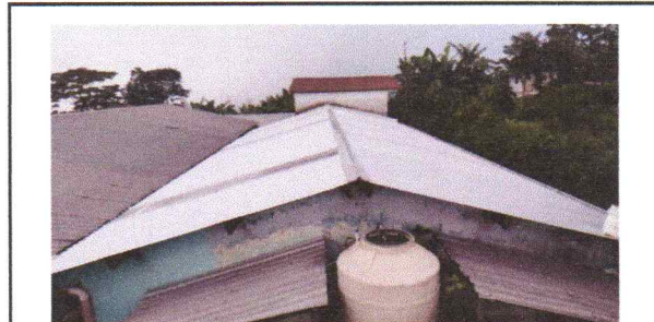
Foto 6: Sustitución de laminas troquelada en cubierta
