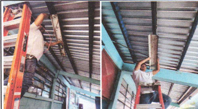
Foto 2: Sustitución de luminarias
