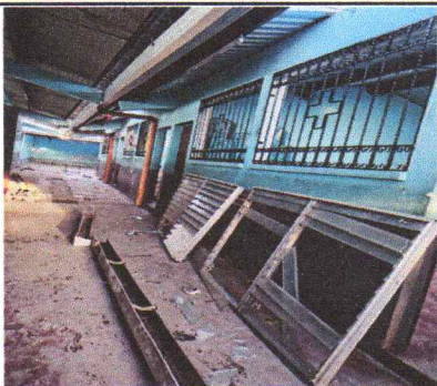
Foto 5: Sustitución de ventanas en pvc
