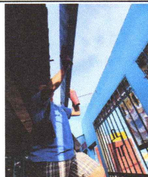
Foto 10: Sustitución de pintura en estructura metálica de techado
