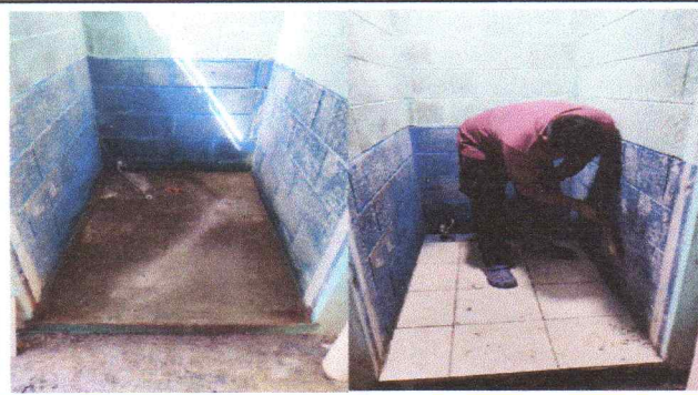
Foto 4: Colocación de Azulejos en baños
