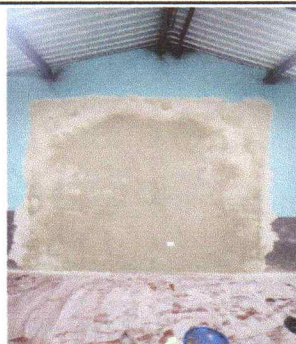
Foto 11: Sustitución de repello en pared
