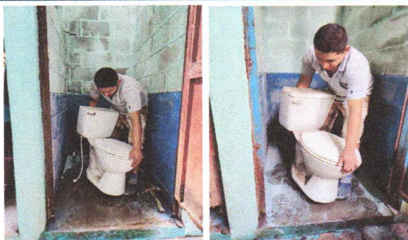
Foto7: Sustitución de inodoros sanitarios
