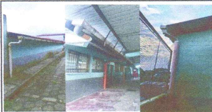
No.1 Sustitucion de canal de metal en cubierta
