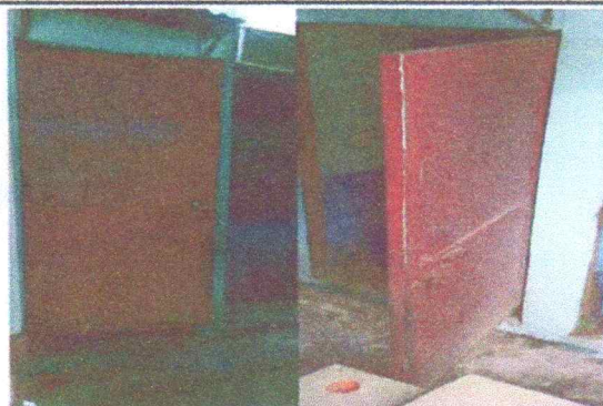
No.3 Sustitucion de pertas metalicas en baños
