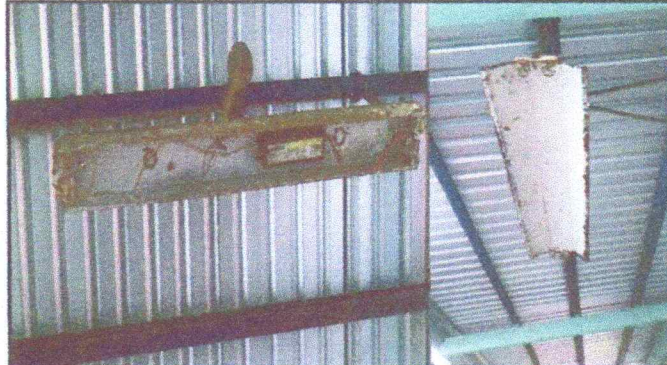
No.2 Sustitucion de luminarias
