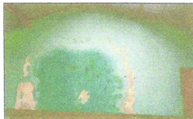
No.11 Sustitución de repello en pared
