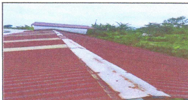
No.6 Sustitucion de lamina troquelada en cubierta
