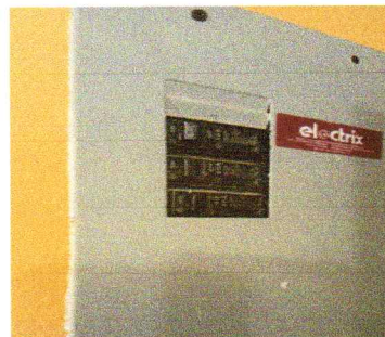
mantenimiento de tablero electrico principal en modulo 2
