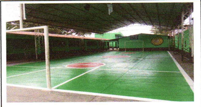
mantenimiento de pintura base acrílico en cancha
