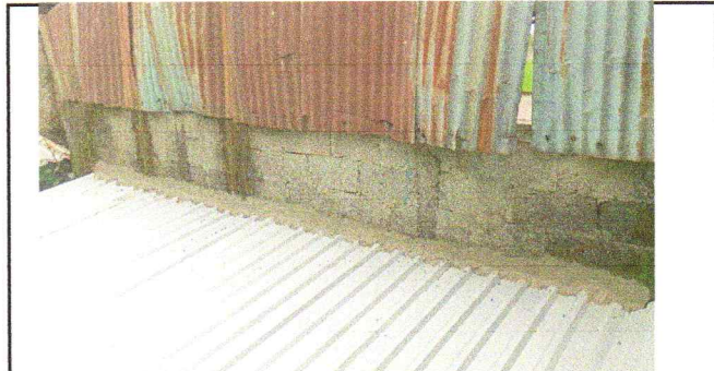
sustitucion de lamina troquelada calibre 26 en baños
