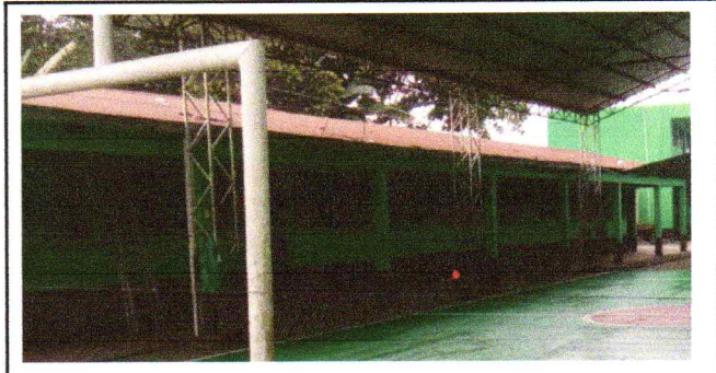
mantenimietno con 2 capas de pintura anticorrosiva negro en balcones
