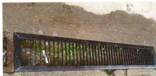
sustitucion reja de drenaje
