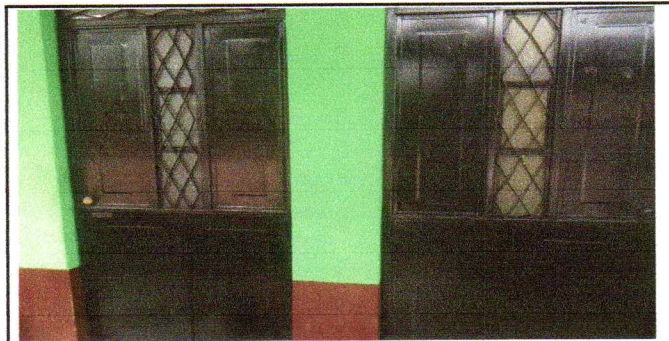
mantenimietnos con 2 capas de pintura negra anticorrosiva en puertas
