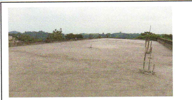
mantenimiento de pañuelos en terraza con torta de cemento
