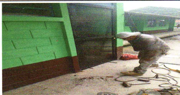
sustitucion de puerta de metal incluye chapa yale
