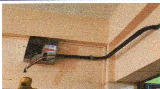
mantenimiento de tablero electrico principal en modulo 2
