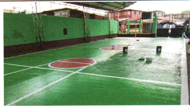
mantenimiento de pintura base acrílico en cancha
