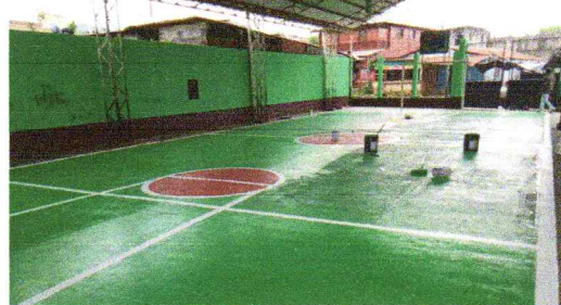
mantenimiento de pintura latex base agua en edificio escolar exterior
