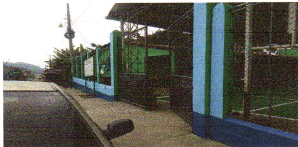
mantenimiento con 2 de pintura anticorrosiva azul en porton
