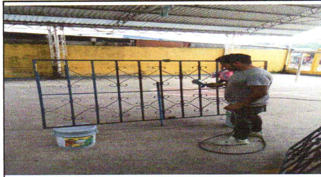
mantenimiento con 2 capas de pintura anticorrosiva azul en balcones
