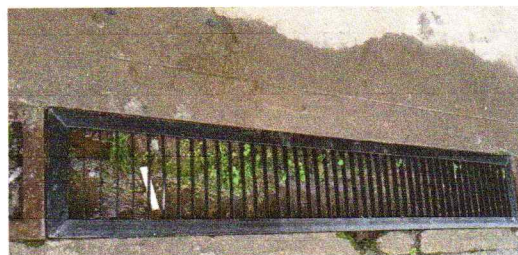
sustitucion reja de drenaje
