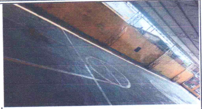
mantenimiento de pintura latex base agua en edificio escolar exterior mantenimiento de pintura base acrílico en cancha
