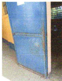
sustitucion de puerta de metal incluye chapa yale
