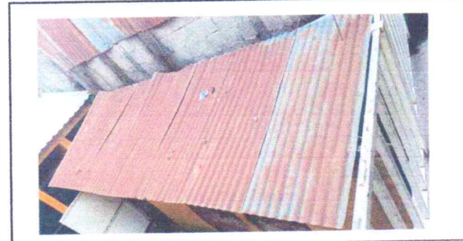
sustitución de lamina troquelada calibre 26 en baños
