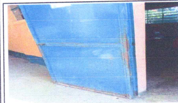
mantenimientos con 2 capas de pintura azul anticorrosiva en puertas
