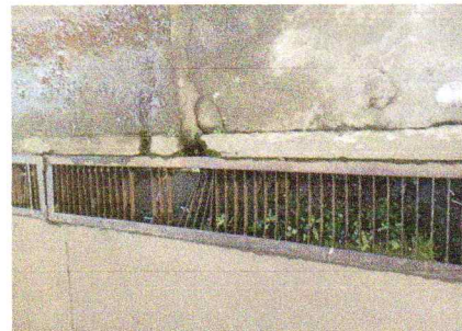
sustitucion reja de drenaje
