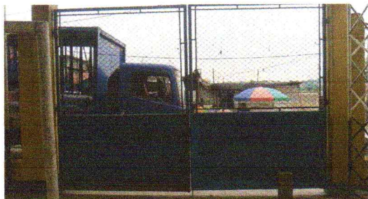
mantenimiento con 2 de pintura anticorrosiva azul en porton
