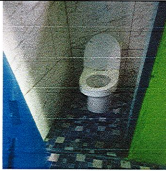
Foto 1: Sustrucción de sanitarios institucionales (incluye accesorios)
