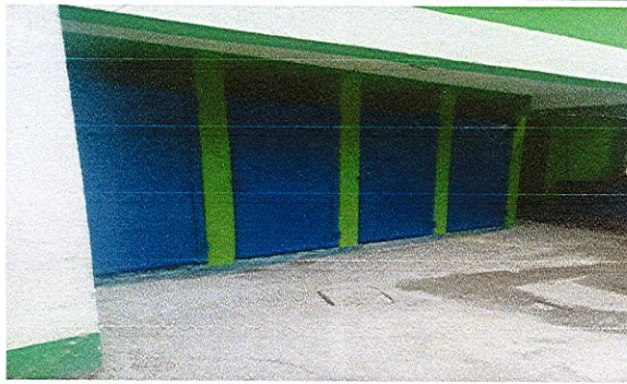
Foto7: Sustrución de puertas de metal.
