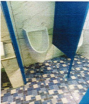
Foto 3: Sustrucción de migitorio seco incluye accesorios.
