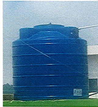
Foto 10: Sustrución de depósito de agua de 1100 Lt. Incluye accesorios.
