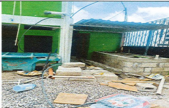
Foto 8: sustitucion de techo con lamina calibre 26 (incluye tornillos, esmalte y silicon)
