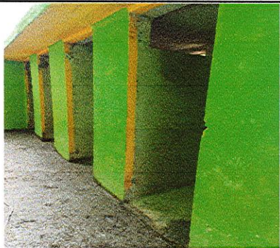
Foto 7: Sustitución de puertas de metal.
