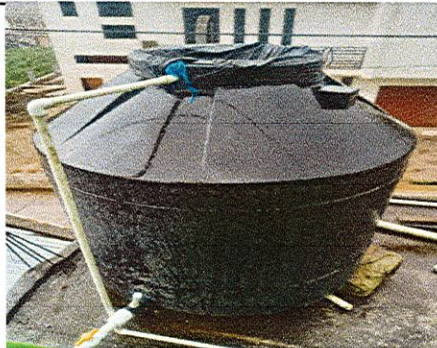
Foto 10: Sustitución de deposito de agua de 1100 lt (incluye accesorios)
