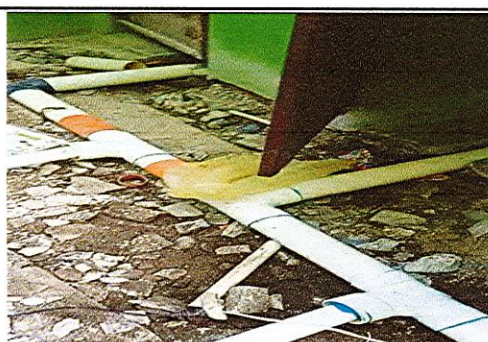
Foto 12: Instalacion hidraulica y sanitarios con tuberia pvc (incluye accesorios)
