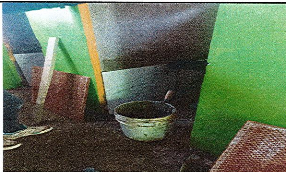
Foto 15: Mantenimiento de sanitario con cerámica (incluye base y pegamento psp)
