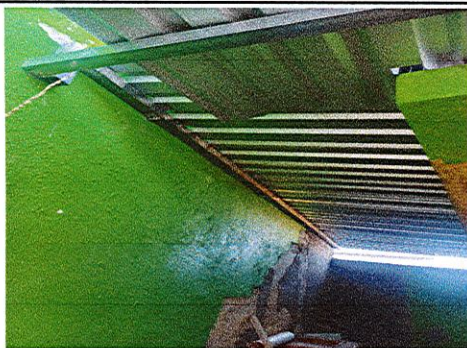
Foto 9: sustitución de soporte de metal galvanizado para techo.
