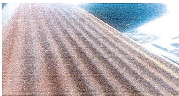
9. Sustitución de soporte de metal galvanizado para techo
