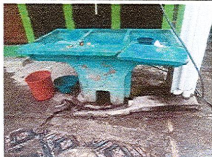
11. Sustitución de pila de concreto con lavaderos y deposito
