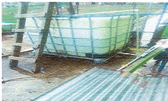
10. Sustitución de depósito de agua de 1100Lt (incluye accesorios)
