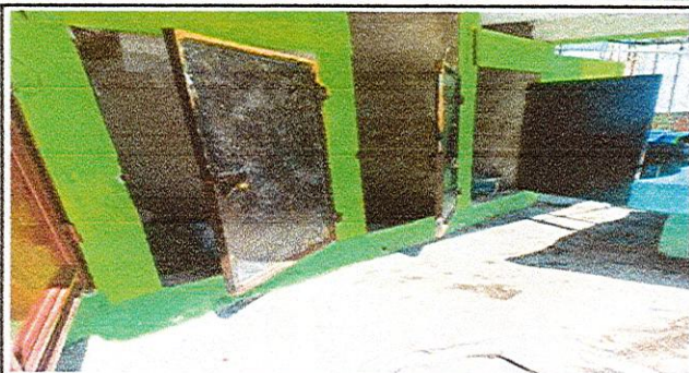
7. Sustitución de puertas de metal
