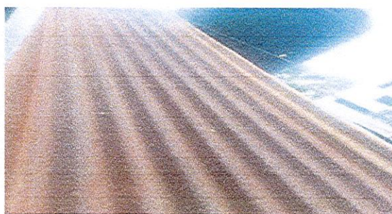
8 Sustitución de techo con lamina C26 (incluye tornillos, esmalte y silicón)
