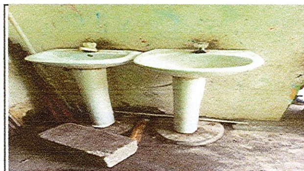
4. Sustitución de base para lavamanos de concreto (incluye azulejo)
