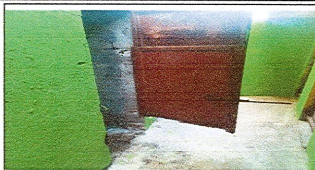
2. Reparación de puerta de metal (corte, lijado y aplicación de pintura anticorrosiva)
