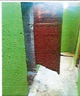
15. Mantenimiento de servicios sanitarios con cerámica (incluye base y pegamento PSP)
