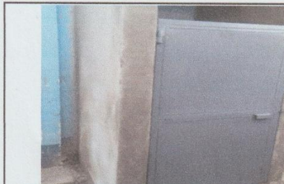
14. Sustitución de puerta, por puerta metálica para baño. (1 Unidad).
