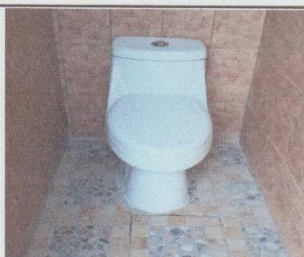
9. Sustitución de tasa sanitaria, por tasa sanitaria de marca reconocida. (3 Unidad).
