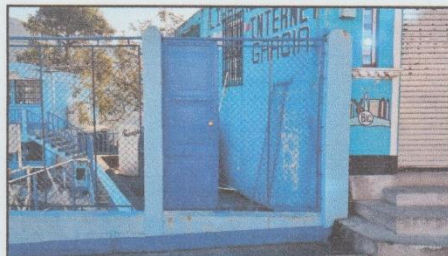
8. Sustitución de puerta, por puerta metálica con chapa. (1 Unidad).
