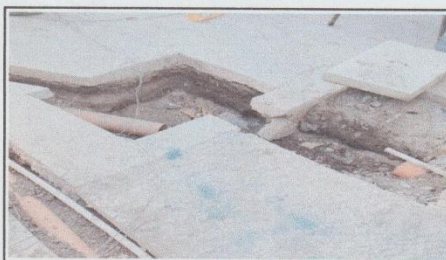
12. Sustitución de tubería, por tubería de 3 pulgadas para drenaje de baños. (30ml).
