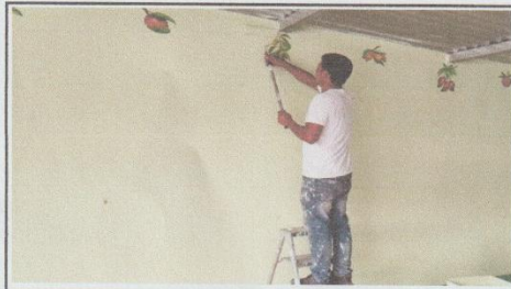
15. Mantenimiento con pintura en área de cocina. (54 m2).
