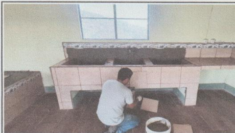
3. Sustitución de azulejo en pila de cocina, por azulejo cerámico y adhesivo de alta resistencia. (6 m2).
