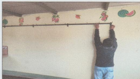
6. Sustitución de estructura para colgador de instrumentos de cocina, por colgador de metal con pintura anticorrosiva. (1 Unidad).
