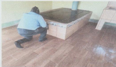
4. Sustitución de azulejo en estufa de leña de cocina, por azulejo cerámico y adhesivo de alta resistencia. (6 m2).
