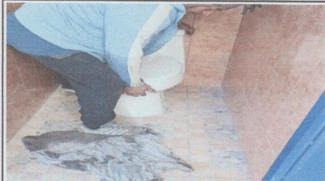
9. Sustitución de tasa sanitaria, por tasa sanitaria de marca reconocida. (3 Unidad).
