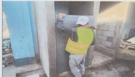
14. Sustitución de puerta, por puerta metálica para baño. (1 Unidad).
