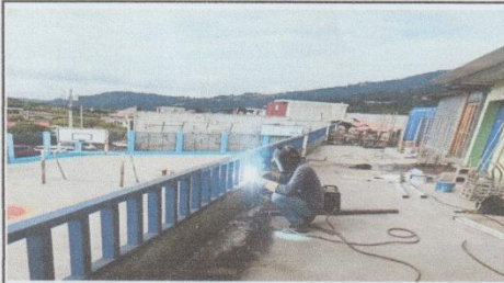
1. Sustitución de baranda en segundo nivel, por baranda de metal de tubo metálico cuadrado de 2 pulgadas en parte inferior y superior, y tubo metálico de 1 1/2 pulgada en área interna, distanciados a 12 cm. Pintado color azul. Con altura de 50 cm. (25 ml).
