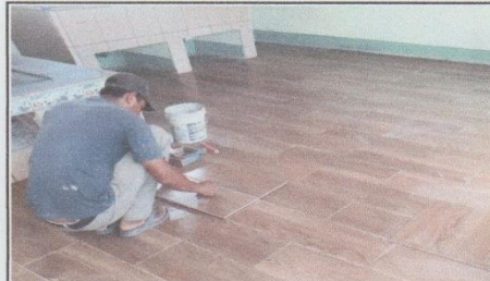
2. Sustitución de piso de concreto en área de cocina, por piso cerámico y adhesivo de alta existencia. (22 m2).
