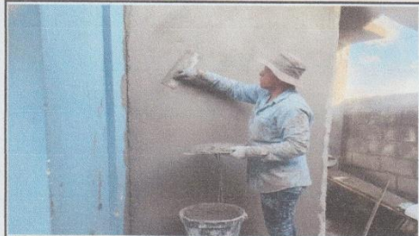
13. Mantenimiento con repello en muros de baños. (20m2).
