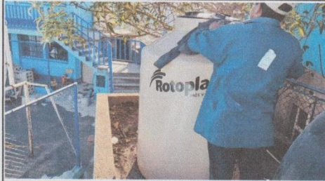
7. Sustitución de tanque elevado, por tanque elevado con capacidad de 1,100 Lt. (1 Unidad).
