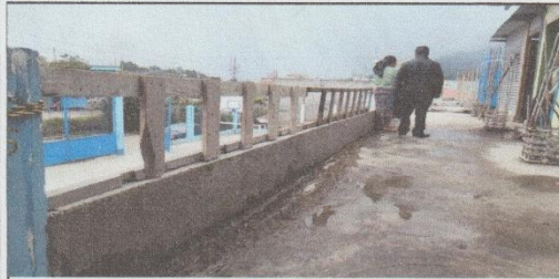
1. Sustitución de baranda en segundo nivel, por baranda de metal de tubo metálico cuadrado de 2 pulgadas en parte inferior y superior, y tubo metálico de 1 1/2 pulgada en área interna, distanciados a 12 cm. Pintado color azul. Con altura de 50 cm. (25 ml).
