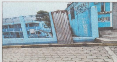
8. Sustitución de puerta, por puerta metálica con chapa. (1 Unidad).
