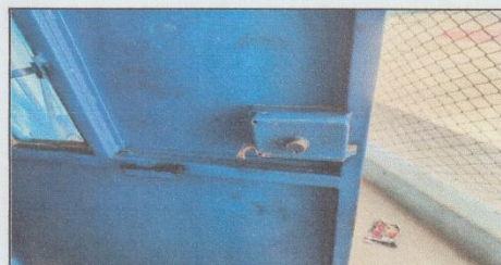
10. Sustitución de chapa de puerta, por chapa de puerta de marca reconocida. (3 Unidad).
