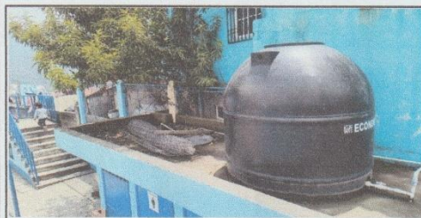
7. Sustitución de tanque elevado, por tanque elevado con capacidad de 1,100 Lt. (1 Unidad).
