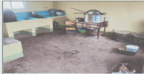
2. Sustitución de piso de concreto en área de cocina, por piso cerámico y adhesivo de alta existencia. (22 m2).
