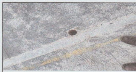
12. Sustitución de tubería, por tubería de 3 pulgadas para drenaje de baños. (30ml).
