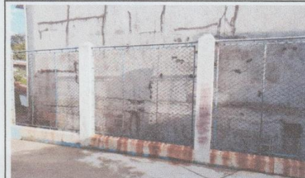
16. Mantenimiento con pintura en malla de circulación. (118 m2).
