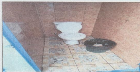
9. Sustitución de tasa sanitaria, por tasa sanitaria de marca reconocida. (3 Unidad).
