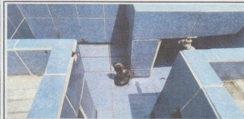
5. Sustitución de válvula de pila, por válvula de aluminio. (1 Unidad).
