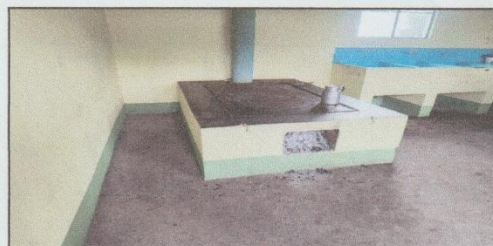
4. Sustitución de azulejo en estufa de leña de cocina, por azulejo cerámico y adhesivo de alta resistencia. (6 m2).
