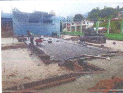
190 metros cuadrados de Sustitución de Losa de patio con Adoquin Clase B 210kg + base de selecto t=8cm compactado
