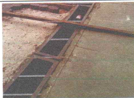
25 metros lineales de Mantenimiento preventivo de patio con canal de concreto 4000psi con regilla 23x27cm para drenaje pluvial
