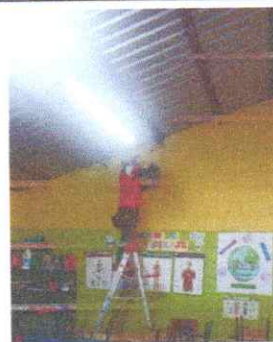
48 metros lineales de Sustitución de circuito de iluminación (incluye cable c12, cable c10, protector flexitubo, abrazaderas)
