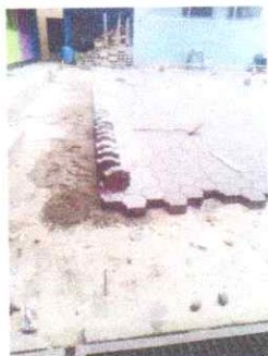
28 metros lineales de Mantenimiento preventivo de adoquinado con fundición de llaves de confinamiento
