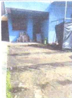
Sustitución de Losa de patio con Adoquin Clase B 210kg + base de selecto t=8cm compactado
