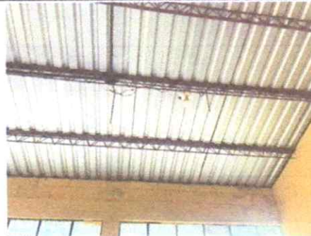
Sustitución de circuito de iluminación (incluye cable c12, cable c10, protector flexitubo, abrazaderas)
