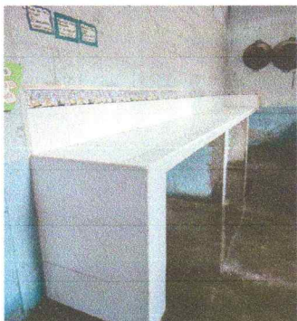
No.1 Sustitucion de zulejo en mesas de trabajo y lavamanos
