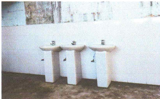
No.13 Sustitución de azulejo en area del lavamanos
