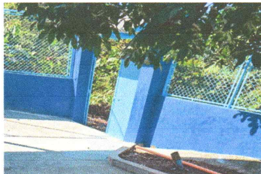
No.14 Mantenimiento correctivo de portón principal
