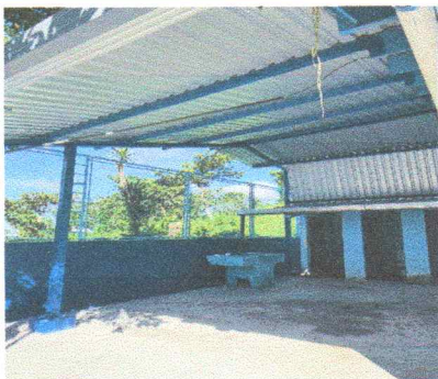
No.7 Sustitucion de lámina troquelada cal. 26 en cubierta
