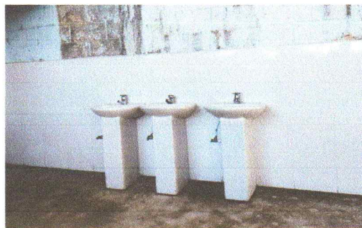
No.4 Sustitucion de lavamanos en sanitarios
