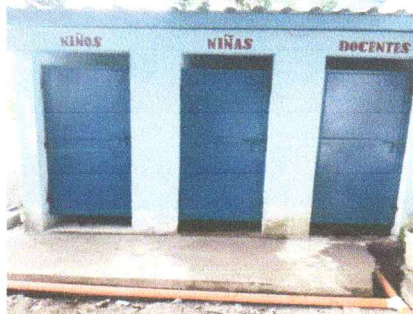
No.5 Sustitución de puertas metalicas
