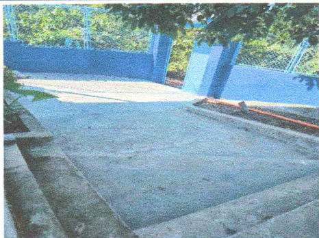
No.9 Mantenimiento correctivo de pintura en reja metálica perimetral
