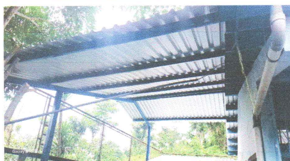
No.8 Sustitución de estructura metálica en cubierta
