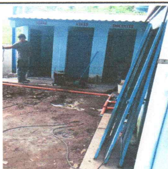
No.5 Sustitución de puertas metalicas
