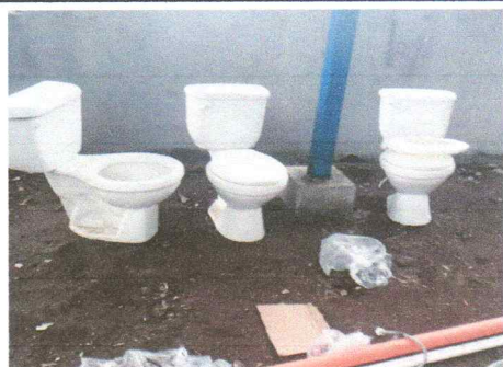
No.3 Sustitucion de inodoros en sanitarios
