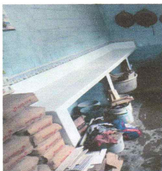
No.1 Sustitucion de zulejo en mesas de trabajo y lavamanos
