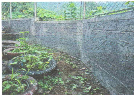
No.10 Mantenimiento correctivo de repello en muro perimetral
