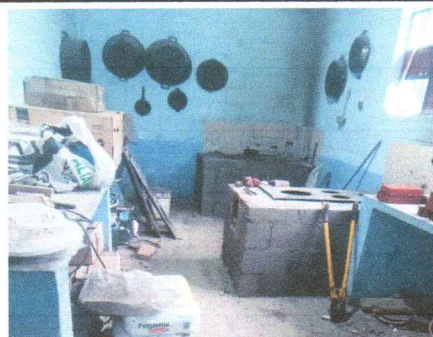
No.2 Sustitución de estufas de leña tipo polleton
