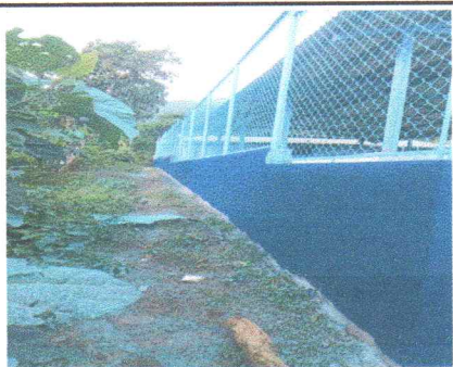
No.11 Mantenimiento correctivo de pintura en muros perimetrales
