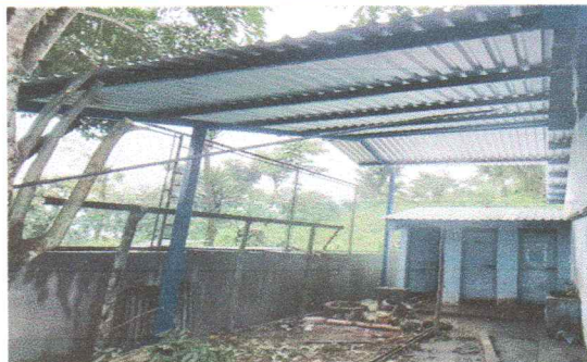
No.8 Sustitución de estructura metálica en cubierta
