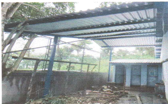
No.7 Sustitucion de lámina troquelada cal. 26 en cubierta
