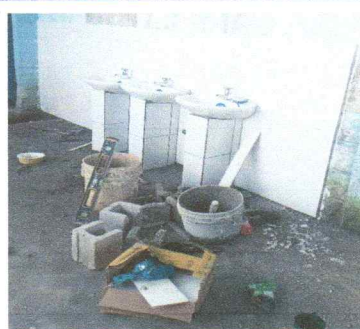
No.4 Sustitucion de lavamanos en sanitarios
