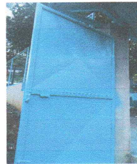
No.14 Mantenimiento correctivo de portón principal
