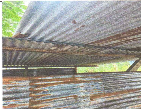
No.8 Sustitución de estructura metálica en cubierta
