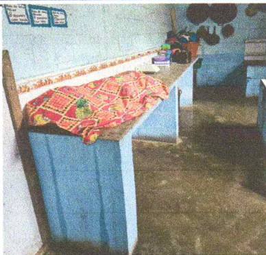
No.1 Sustitucion de zulejo en mesas de trabajo y lavamanos
