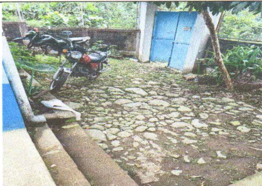
No.9 Mantenimiento correctivo de pintura en reja metálica perimetral
