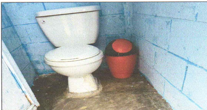
No.3 Sustitucion de inodoros en sanitarios
