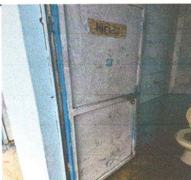
No.5 Sustitución de puertas metálicas
