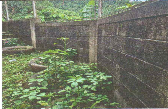
No.10 Mantenimiento correctivo de repello en muro perimetral
