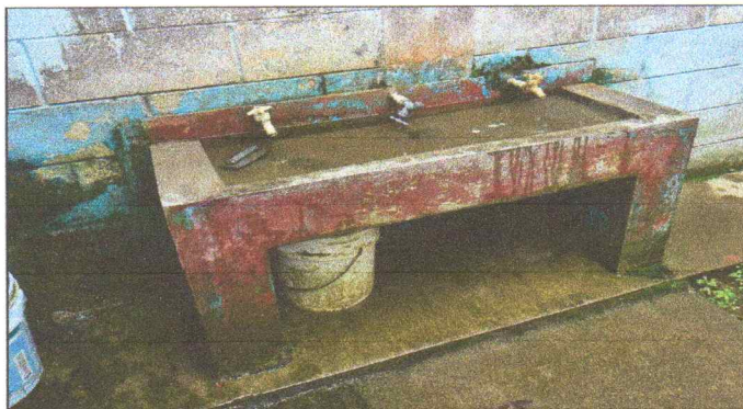
No.4 Sustitucion de lavamanos en sanitarios
