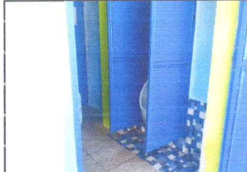
1 unidad de Sustitución de mingitorio seco (incluye accesorios)
