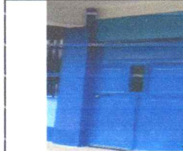
5 unidades de Mantenimiento preventivo de puertas de metal (limpieza + 3 capas de pintura anticorrosiva)
