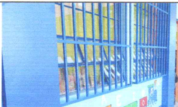
38 metros cuadrados de Mantenimiento preventivo de ventanas con baranda de metal + pintura anticorrosiva
