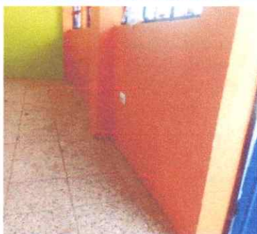
625 metros cuadrados de Mantenimiento preventivo de muros con pintura acrílica interior y exterior
