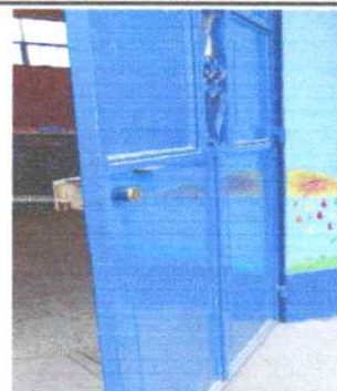
5 unidades de Mantenimiento preventivo de puertas de metal (limpieza + 3 capas de pintura anticorrosiva)
