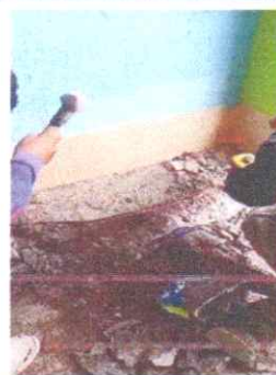
1 unidad de Sustitución de mingitorio seco (incluye accesorios)
