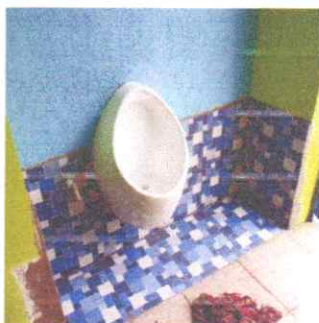
3.5 metros cuadrados de Mantenimiento de servicios sanitarios con cerámica
