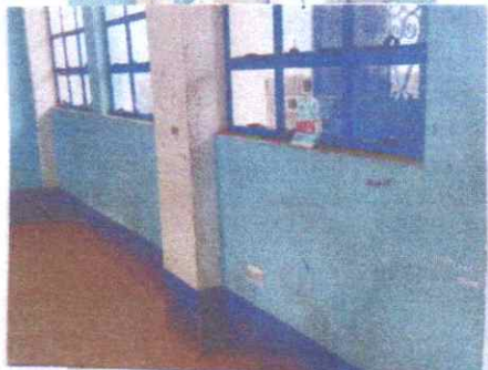
Mantenimiento preventivo de muros con pintura acrílica interior y exterior
