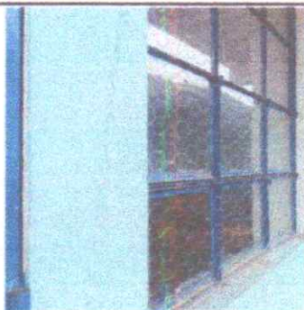
Mantenimiento preventivo de ventanas con baranda de metal + pintura anticorrosiva
