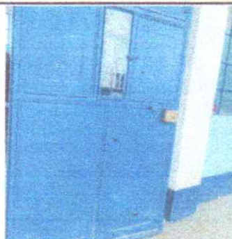
Mantenimiento preventivo de puertas de metal (limpieza + 3 capas de pintura anticorrosiva)
