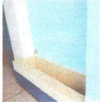
Sustitución de mingitorio seco (incluye accesorios)
