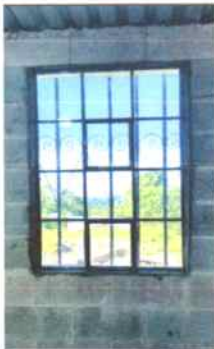
Foto 3: Metros cuadrados de sustitución de ventana de metal, incluye vidrio de 5mm
