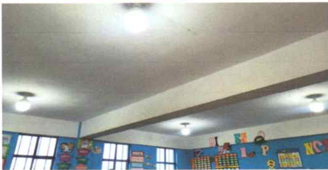
Foto 11: Unidades de sustitución de unidades electricas por plafonera mas focos led 50 wats
