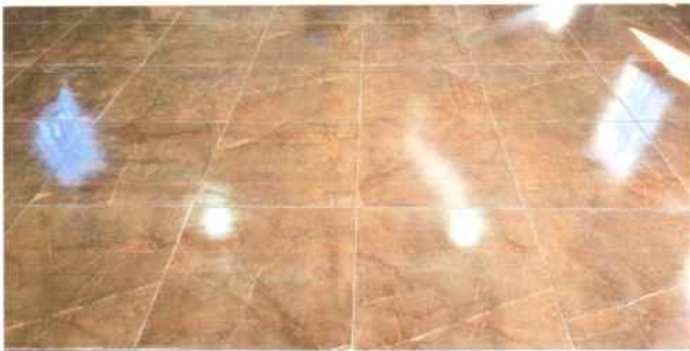
Foto 5: Metros cuadrados de sustitucion de piso de concreto por piso cerámico antideslizante
