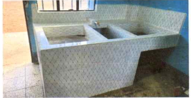
Foto 2: Sustitución de pila por tanque de agua + 2 lavaderos incluye azulejo
