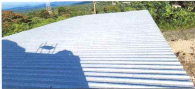
Foto 9: Metros cuadrados de sustitución de lamina troquelada calibre 26 aluzin
