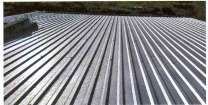
Foto 10: Metros cuadrados de sustitución de lamina troquelada calibre 26 aluzinc en cocina y baños
