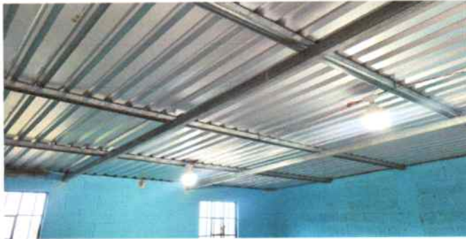
Foto 7: Metros cuadrados de sustitución de estructura de metal por estructura de metal galvanizado
