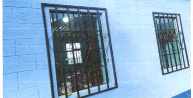
Foto 4: Metros cuadrados de Sustitución de balcón de metal de reja
