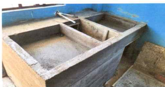
Foto 2: Sustrucción de pila por tanque de agua + 2 lavaderos incluye azulejo
