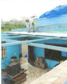
Foto 9: Metros cuadrados de sustitución de lamina troquelada calibre 26 aluzin
