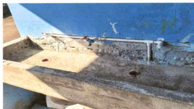
Foto 6: Metros lineales de sustrucción de lavamanos por lavamanos de concreto incluye accesorios y azulejo
