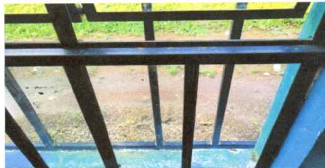
Foto 8: Metros cuadrados de sustitución de sustitución de ventana corrediza incluye vidrio 5mm
