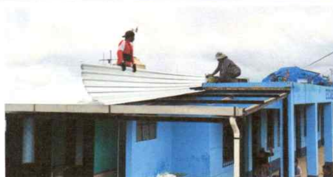
Foto 10: Metros cuadrados de sustitución de lamina troquelada calibre 26 aluzinc en cocina y baños
