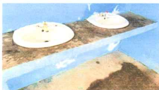
No.6 Sustitución de lavamanos por lavamanos de concreto incluye accesorio y azulejo
