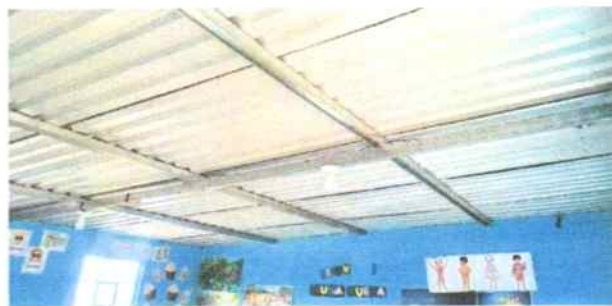
No.7 Sustitución de estructura de metal
