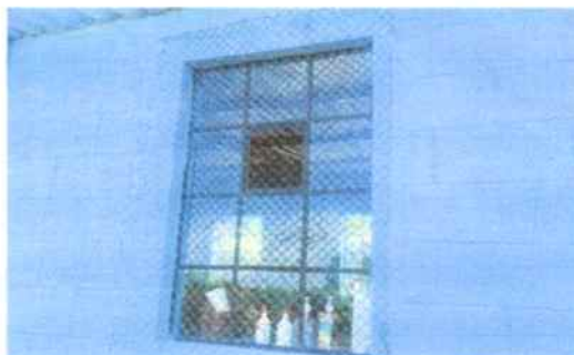
No.4 Sustitución de de valcon de metal de reja
