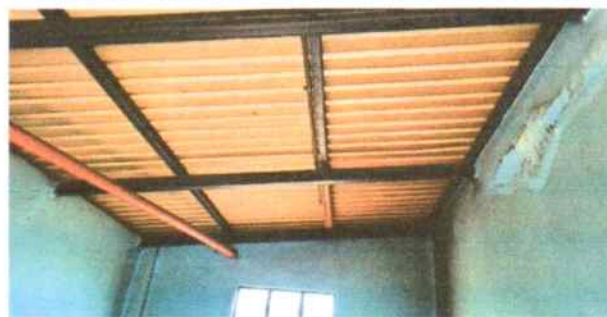
No.10 sustitucion de lamina troquelada calibre 26 aluzinc en cocina y baño.
