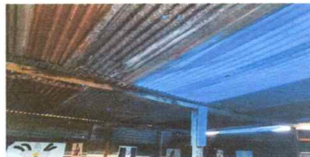
No.9 sustitucion de lamina troquelada calibre 26 aluzinc
