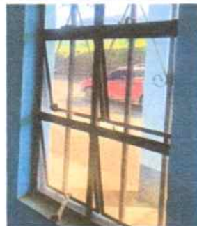
No.8 Sustitucion de ventana corrediza incluye vidrio de 5mm
