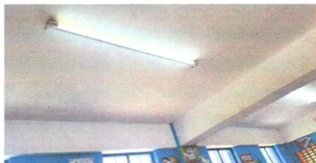
No. Sustitución de electricas por plafoneras mas foco led 50 watts.
