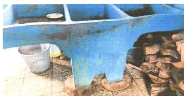
No.2 Sustitución de pila por tanque de agua mas dos lavamanos incluye azulejo
