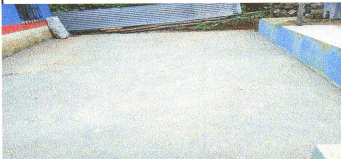
Foto 1: Sustrucción de piso de concreto t=0.05 mts en patio
