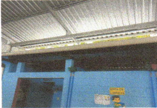
Foto 13: Susutitución de canal pvc en baños y dirección
