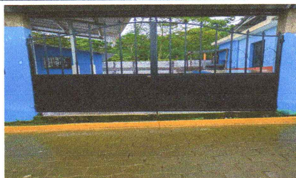
Foto 4: Mantenimiento de pintura anticorrosiva en porton principal
