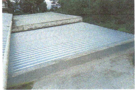
Foto 14: Susutitución de lamina troquelada alizinc calibre 26 en cubierta de direcci+on y baño
