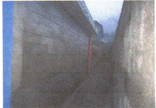
Foto 8: Sustitución de tubería para bajadas de agua pruvial en edificio escolar
