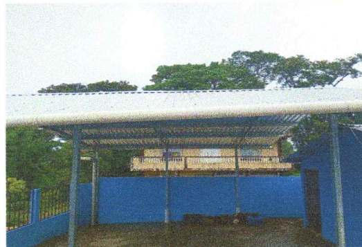
Foto 2: Sustrucción e instalación de lámina troquelada aluzinc calibre 26 en cubierta de galera
