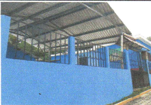
Foto 11: Mantenimiento de pintura en muro y aula #1
