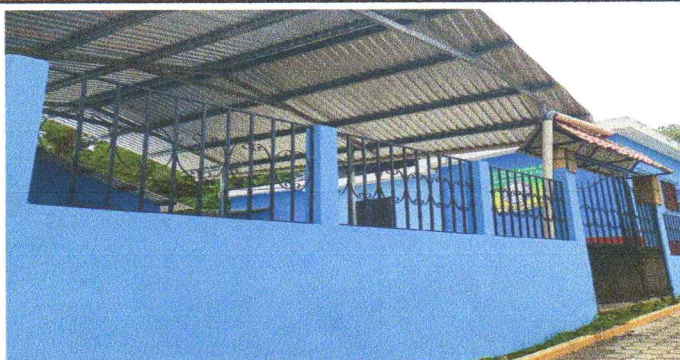
Foto 3: Mantenimiento de pintura en barandas de metal de muro perimetral
