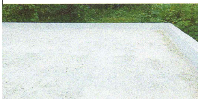
Foto 5: Mantenimiento en repello de losa final en modulo 1, 2, 3 y 4
