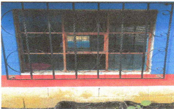
Foto 9: Reparación de ventanas con vidrios claro de 40*40 cms de 5mm en cocina
