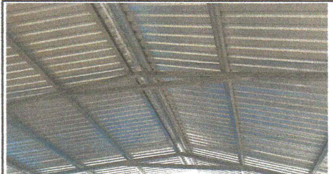
Foto 12: Sustitución de estructura metálica con tubos de 4*4 chapa 16 en galeras
