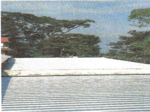
Foto 7: Mantenimiento de loza impermeabilizante acrílico en edificio escolar
