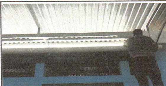
SUSTITUCION DE CANALPVC ALTO FLUJO EN BAÑOS Y DIRECCON
