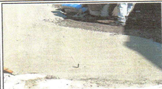
SUSTITUCION DE PISO DE CONCRETO GR50S 5 CMS
