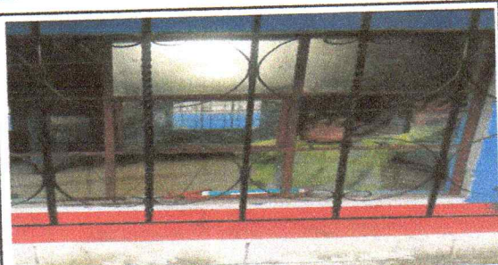
REPARACION DE VENTANAS CON VIDRIOS CLARO DE 40*40 CMS.DE 5 MM EN COCINA
