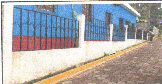
MANTENIMIENTO DE PINTURA EN BARANDAS DE METAL DE MURO PERIMETRAL
