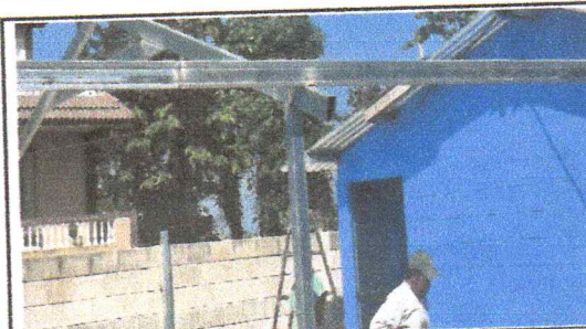
SUSTITUCION DE ESTRUCTURA METALICA CON TUBOS DE 4*4 CHAPA 16 EN GALERA
