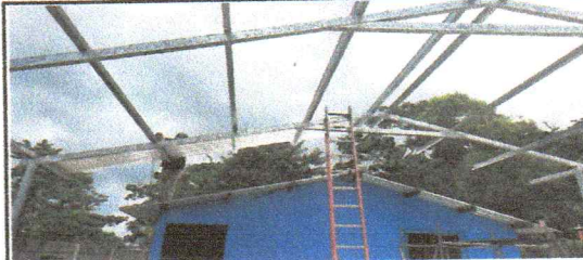
SUSTITUCION DE LAMINA TROQUELADA CALIBRE 26 EN CUBIERTA DE GALERA
