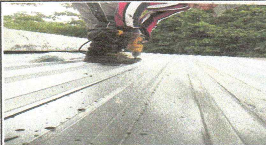
SUSTITUCION DE LKAMINA TROQUELADA ALUZINC CALIBRE 26 EN CUBIERTA DE BAÑOS Y DIRECCION
