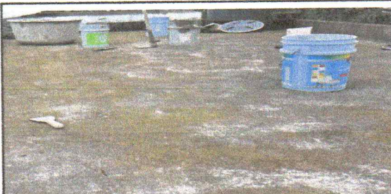
MANTENIMIENTO CON REPEYO EN CONTORNO DE TERAZA
