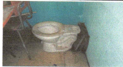
sustitucion de inodoro en sanitario de mujeres
