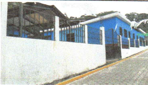
Mantenimiento de pintura en muro y aula #1
