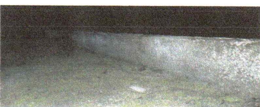
mantenimiento de repello en bordillo de losa final en modulo # 1,2,3,4
