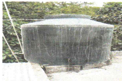
sustitucion de deposito de tanque sistema rotoplas capacidad 1,100 lts
