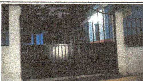
mantenimiento de pintura anticorrosiva en porton principal
