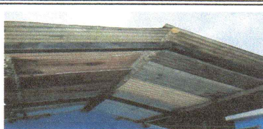
sustitucion de lamina troquelada aluzinc calibre 26 en cubierta de galera
