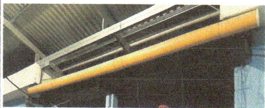
sustitucion de canal pvc alto flujo en baños y direcccion
