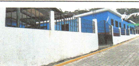
mantenimiento de pintura en barandas de metal de muro perimetral
