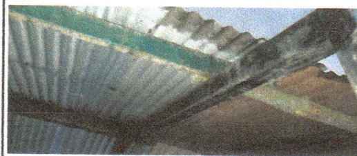
sustitucion de estructura metalica con tubos de 4x4 chapa 16 en galera
