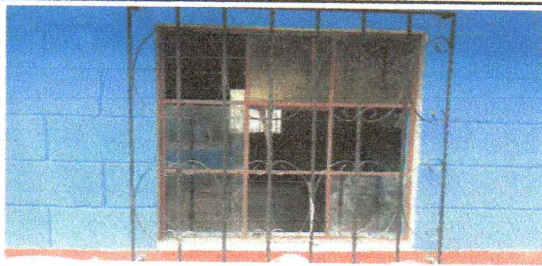
reparacion de ventanas con vidrios claro de 40x40 cms.de 5 mm en cosina
