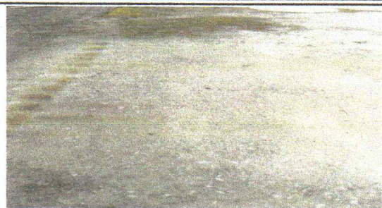
sustitucion de piso de concreto t=0.05 mts.en patio
