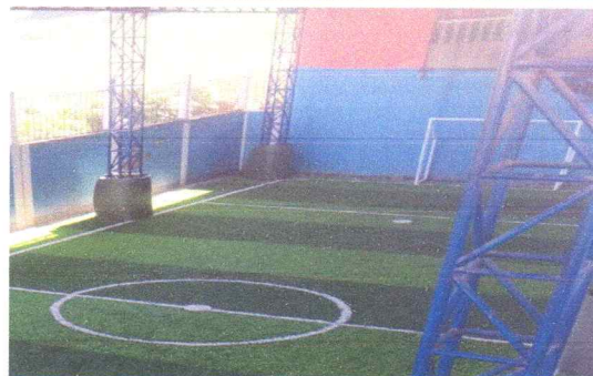
Foto 2: Colocacion de porterias de metal en cancha deportiva.
