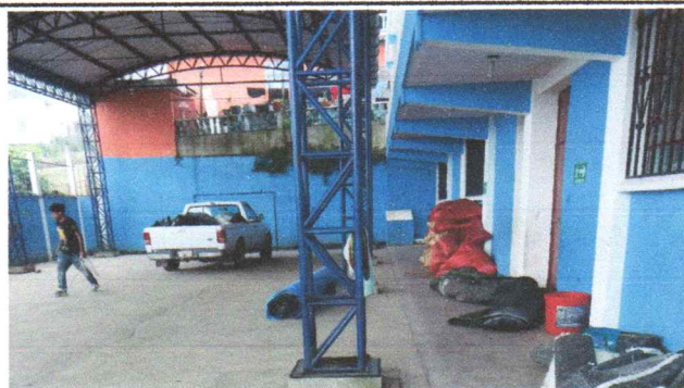
Foto 3: sustitución de piso en acabado de concreto a gramilla sintética en cancha deportiva.
