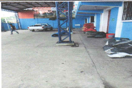
Foto 2: sustitución de porterías de metal en cancha deportiva.
