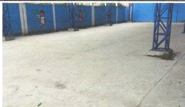
sustitucion de piso en acabado de concreto a gramilla sintetica en cancha deportiva
