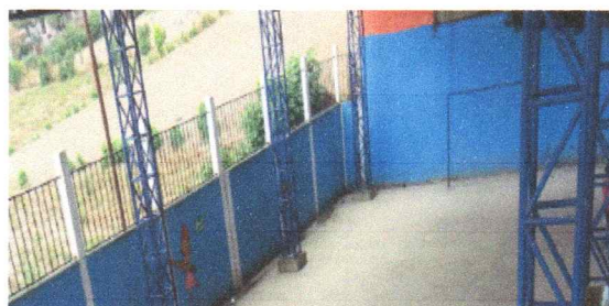
sustitucion de porterias de metal en cancha deportiva
