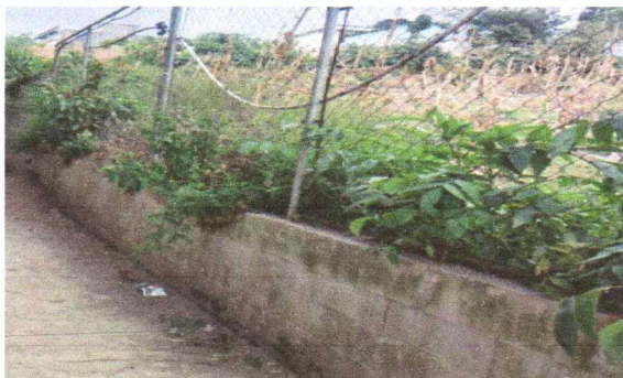
mantenimiento de pared de block en contorno de escuela educativa
