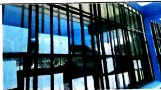
Foto 6: Mantenimiento estructura metal ventanas
