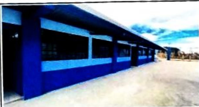
Foto 3: Aplicación de pintura exterior latex azul pantone 293 para zocalo 4 hiladas para muros en fachadas
