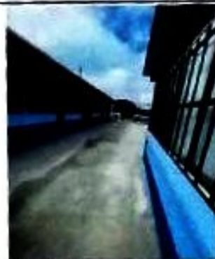
Foto 4: Balcones nuevos instalados
