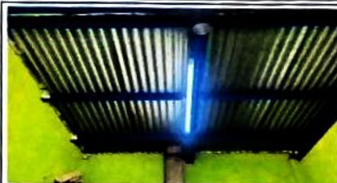
Foto 2: Sustitución de bombillos existentes por lamparas LED tipoliston (incluye lamparas, bases, ugeción de poliducto colgante y mano de obra)
