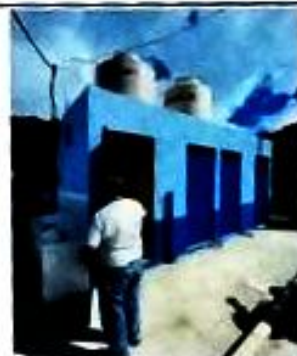
Foto 6: depósito de agua instalado
