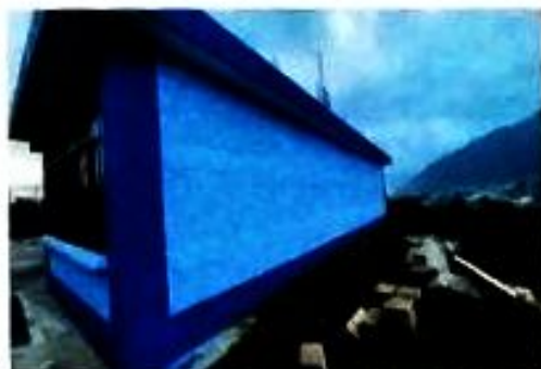
Foto 1: Fachada exterior de aulas y zócalos pintados
