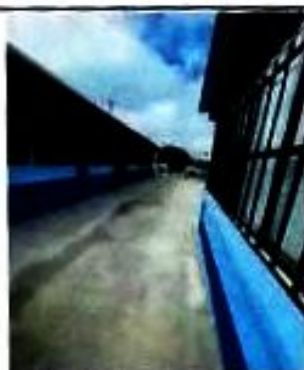
Foto 3: Balcones y ventanales pintados
