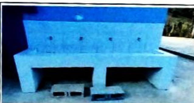
Foto 6: Susstitución de lavamanos de concreto 2,15 mt x 0,50 mt (incluye azulejoeado en lavamanos, azulejo en pared, 4 grifos mas niples HG, reparación de manga de drenaje, sustitución de tubería PVC)
