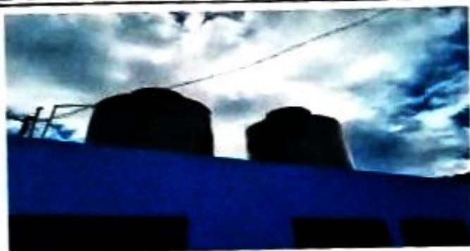
Foto 1: Instalación de depósito de agua 1100 lts (mas accesorios y tubería)
