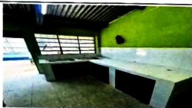
Foto 3: Sustitución de mesa de trabajo de madera por mesa de trabajo en concreto 4,20mt x 0,70 mt (incluye azulejoeado en mesa de concreto, azulejo en pared, divisiones de concreto y puertas de madera, 2 fosas)
