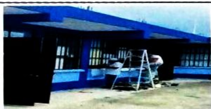
Foto 5: Mantenimiento de estructura de metal balcones
