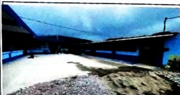
Foto 3: Aplicación de pintura exterior latex azul pantone 293 para zocalo 4 hiladas para muros en fachadas
