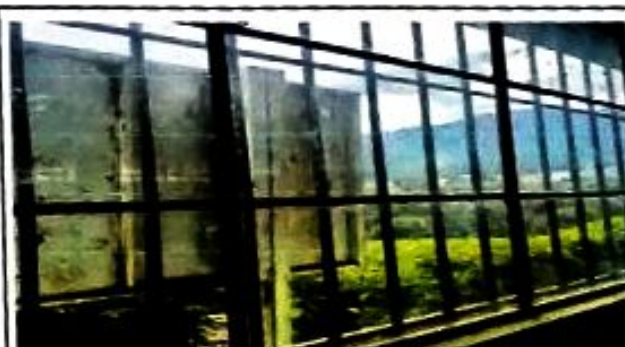
Foto 6: Mantenimiento estructura metal ventanas
