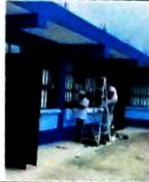
Foto 2: limpieza y lijado para ventanales de aulas
