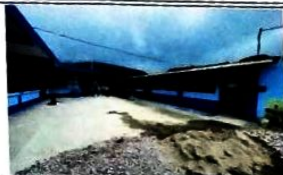
Foto 2: Aplicación de pintura latex celeste pantone 293 para muros de fachada
