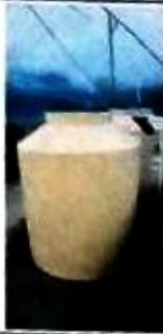
Foto 1: Instalación de depósito de agua
